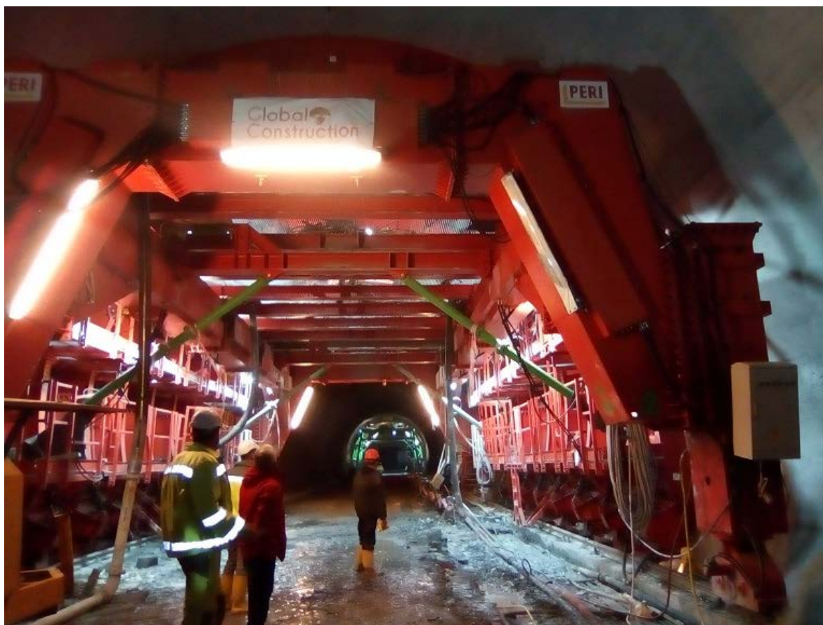
Снимка № 8. Напредък на строителните дейности в подучастък 2 – поставяне на вторична облицовка на тунела
