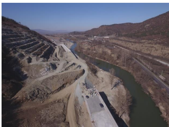
Снимка 4. Свлачище от северната страна на подучастък 1, до лявото платно на моста (2021 г.)
