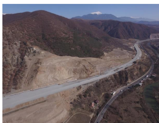
Снимка 5. Свличане на земни маси в подучастък 3, от дясната страна на пътя (2021 г.)
